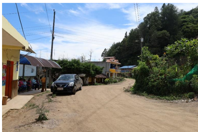
Figura 11. Estado de la Vía principal El Airo - Parroquia El Airo
